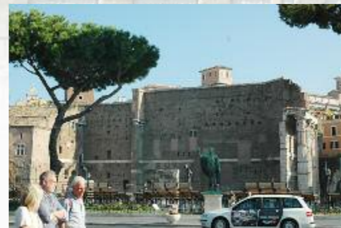
Die Brandmauer zwischen Kaiserforen und Plebs.
